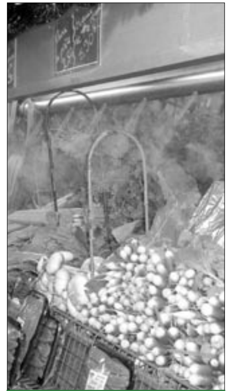
Systeme de nébulisation installé en magasin
